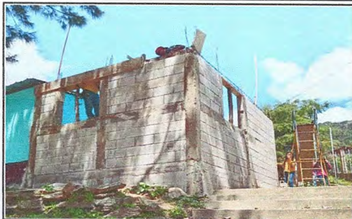
Foto 1: Area donde se esta realizando el mejoramiento de la estructura tipo portico para la cocina.
