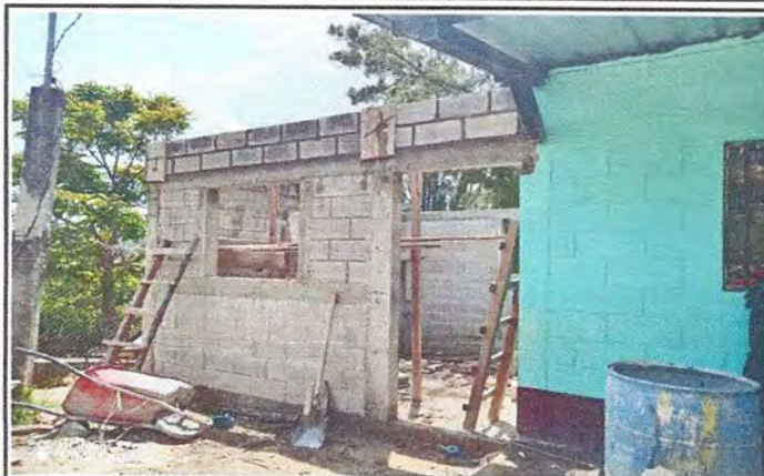
Foto 2: Area frontal, donde se esta realizando el mejoramiento las paredes y la estructura tipo portico para la cocina, piso y polleto como tambien ventanas y puertas.
