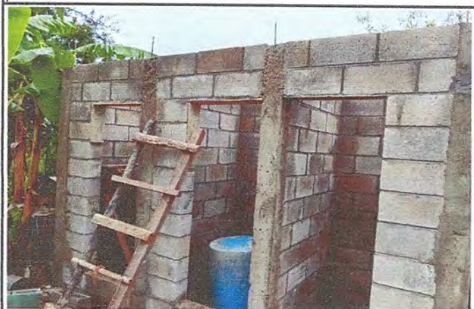
Foto 4: Area frontal, donde se esta realizando el mejoramiento de las paredes, piso y de sanitarios lavables.
